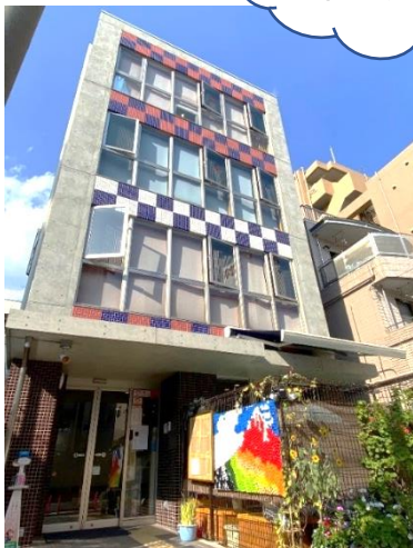
園舎外観写真
