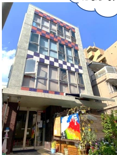
園舎外観写真
