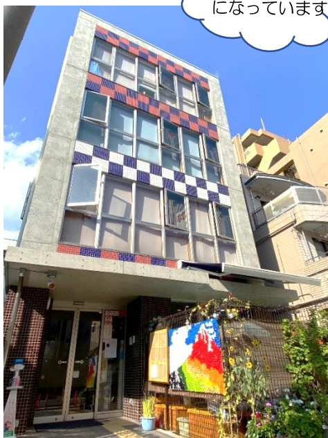
園舎外観写真
